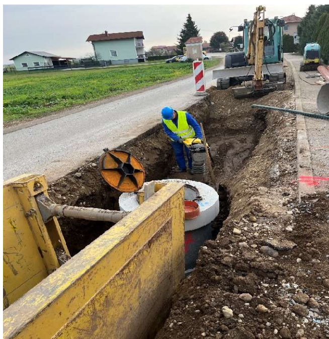
Izgradnja kanalizacije Lancova vas
