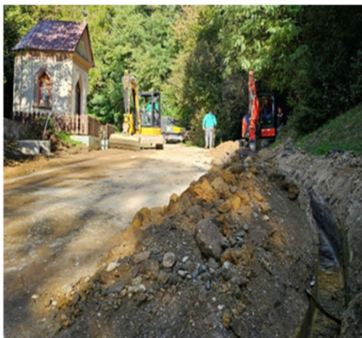
Izgradnja optičnega omrežja
